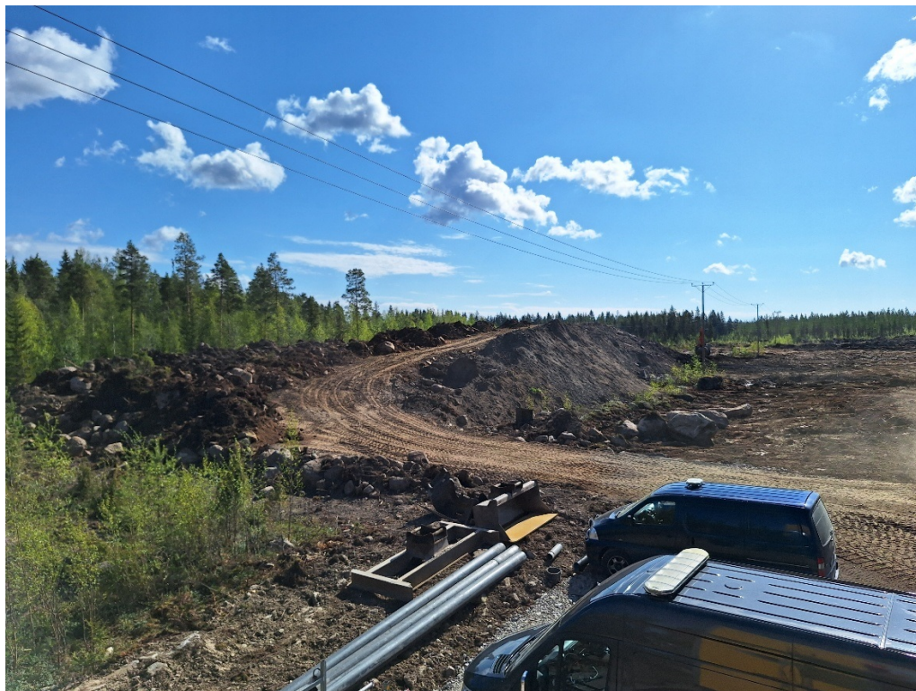
Kuva 3: Tarkastukselta otettu kuva meluvallin alkuosasta (H.E 27.5.2025)
