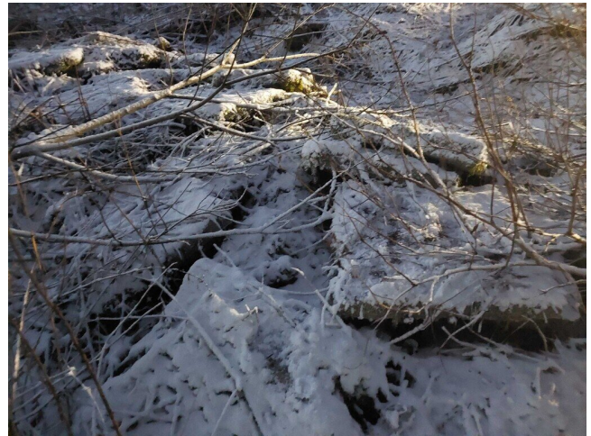
KK4 vieressä suuria betonilaattoja
