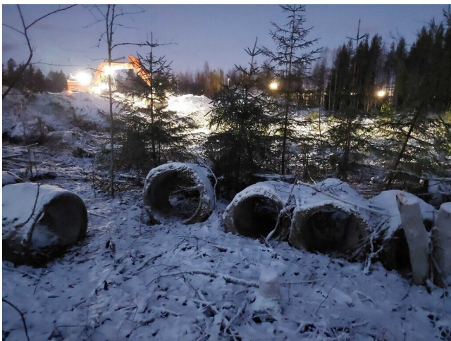
Betonielementtejä, kaivonrenkaita
