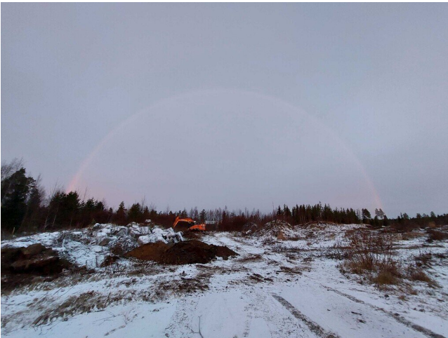
Alueen luoteisosa, KK7 kaivuu
