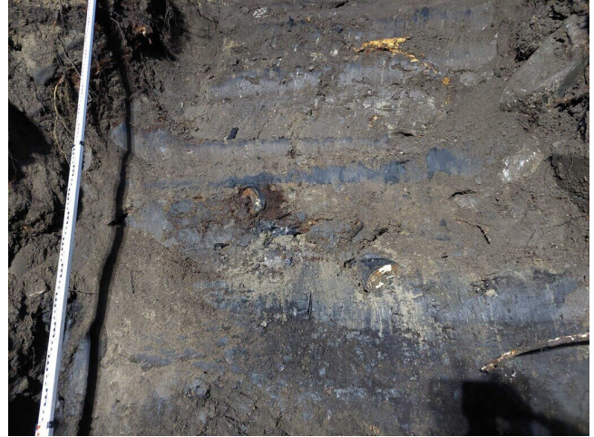
Kaukolämpöputken paloja kasan täytössä
