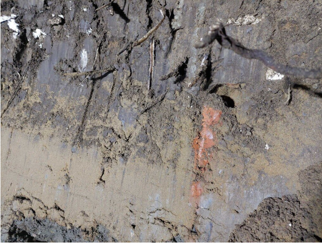
Tiiltä vaaleanuskeassa hiekkakerroksessa. Yläpuolella styroxia tummassa hiekka/multakerroksessa.
