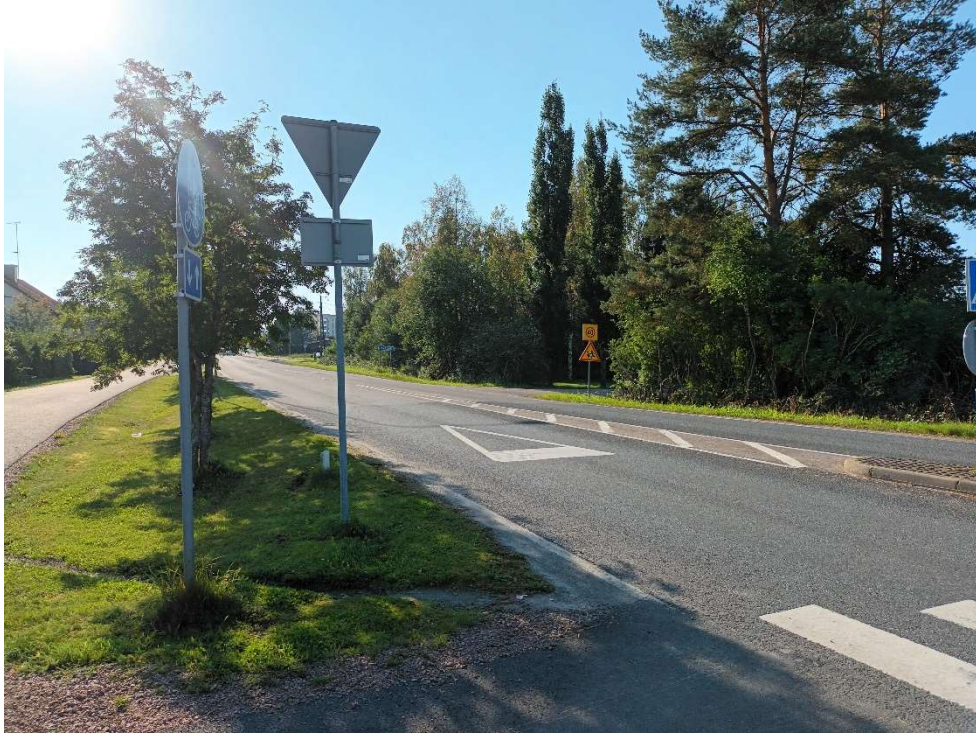
Kuva 5. Näkymä Hakalahdenkadulle Ouluntien risteyksestä.
