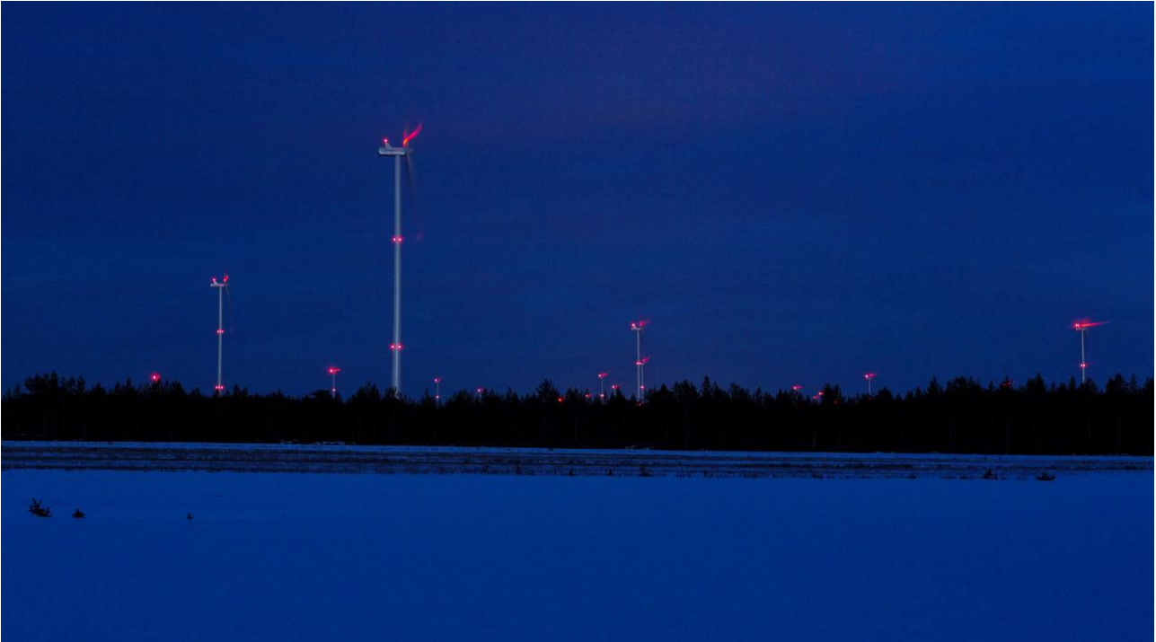
Kuva 67. Kiinteät punaiset lentoestevalot pimeällä. (Kuva: FCG)
