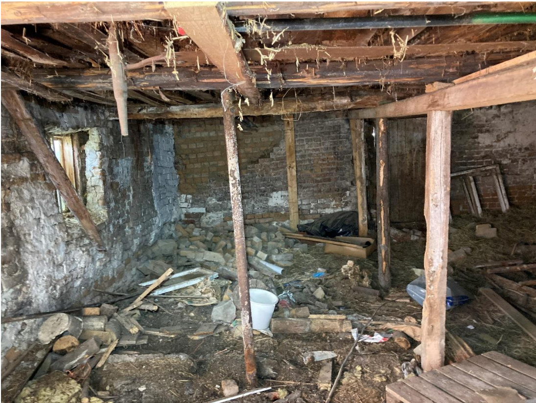
Kuva 5. Purettava navettarakennus sisältä.
