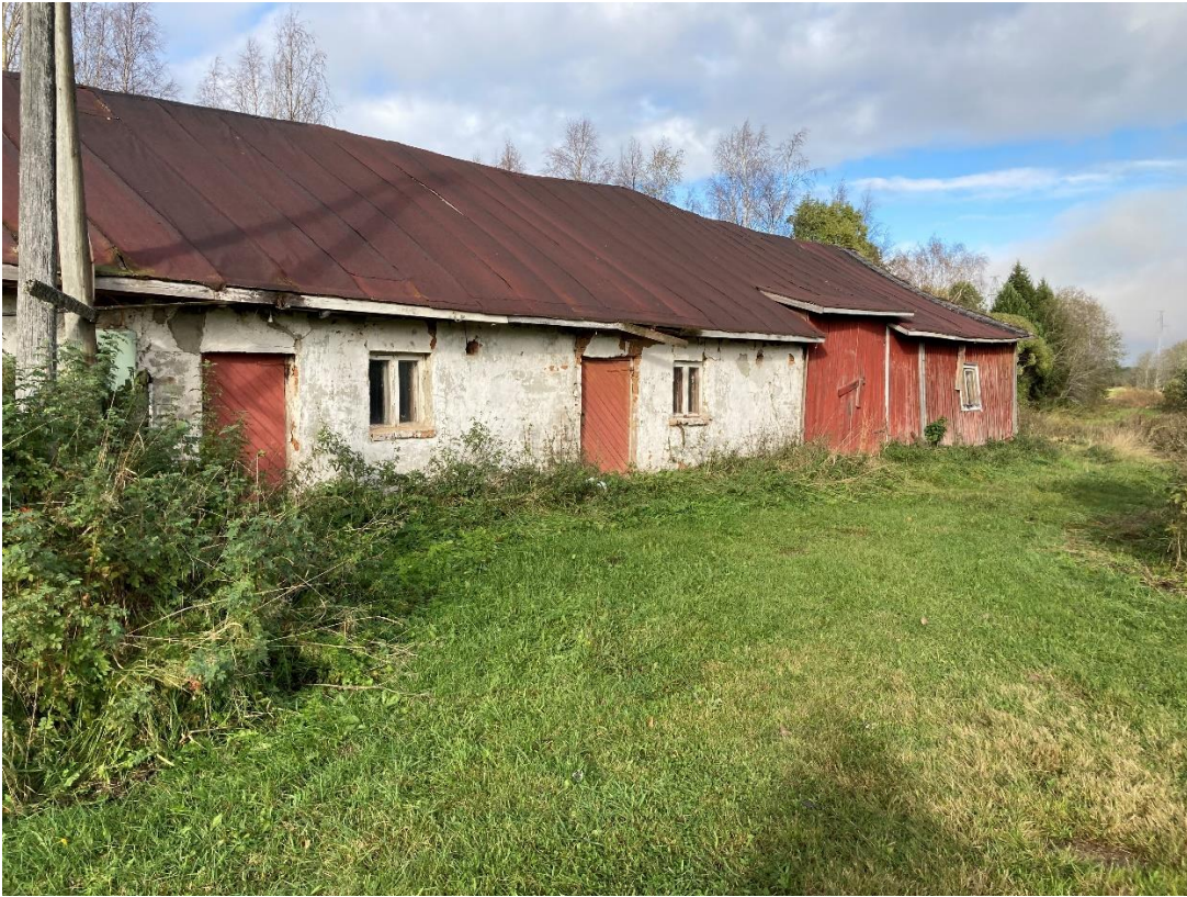
Kuva 4. Purettava navettarakennus ulkoa.
