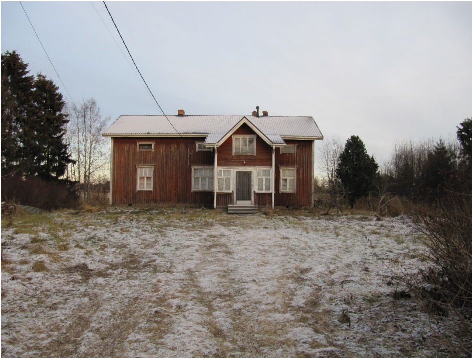
Kuva 18. Kiinteistö 977-406-0012-0102: asuinrakennus (asumaton), v. 1920.
