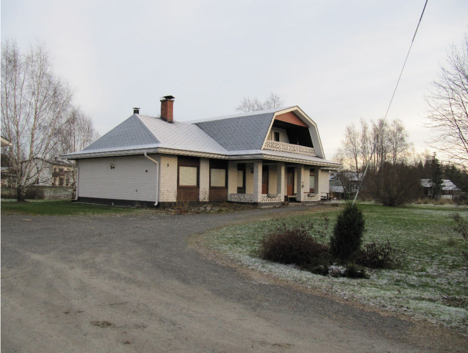
Kuva 21. Kiinteistö 977-406-0012-0067: päiväkotikäytössä, v. 1983.
