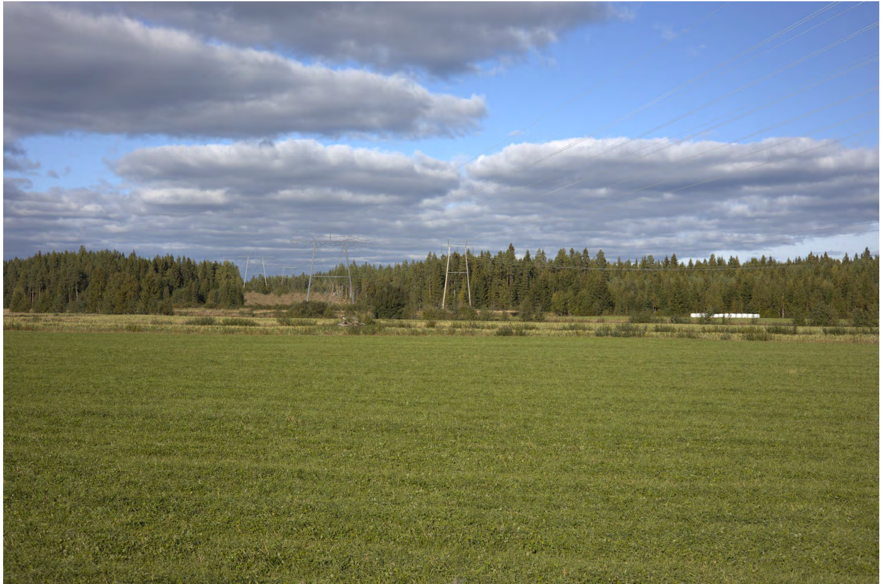
Kuva 117. Kuvauspiste 2. Havainnekuva SVE3a-sähkösiirtoreitin ilmajohdosta Rautiontieltä läheltä Vasaman pihapiiriä. Kuvassa näkyvä oikeanpuoleisin johtopylväs on nykyisen ilmajohdon pylväs, ja vasemmalla näkyvät johtopylväät mallinnettuja SVE3a-reitin johtopylväitä.
