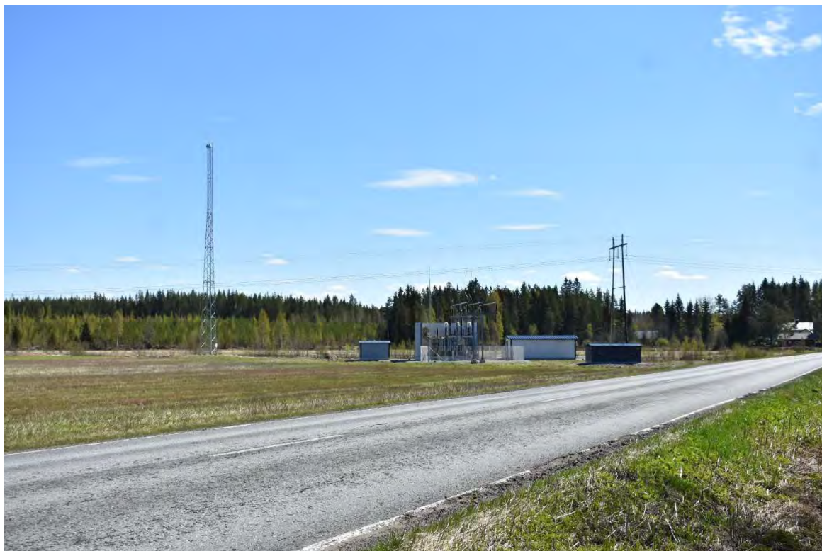
Kuva 29. SVE3a Vasaman peltoalueella, Rautiontien ylityskohdassa.
