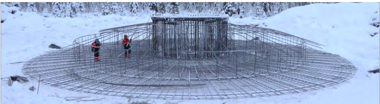
Kuva 1: Pajukoski I työmaa 2015
