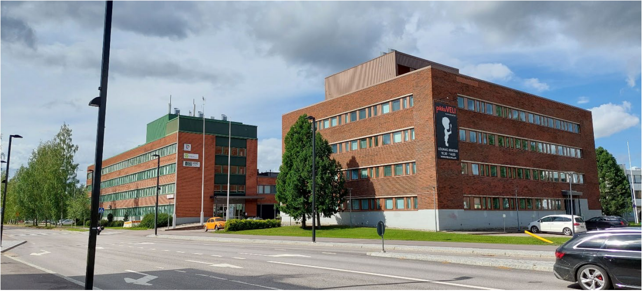
Kuva 6. Suunnittelualueen pohjoisosan virastorakennukset Valtakadun ja Asemakadun risteyksestä nähtynä.
