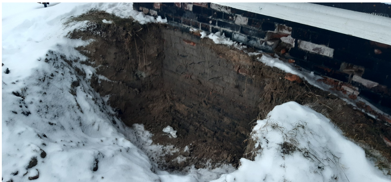
Maamassan poiston jälkeen paljastunut ulkoseinä.
