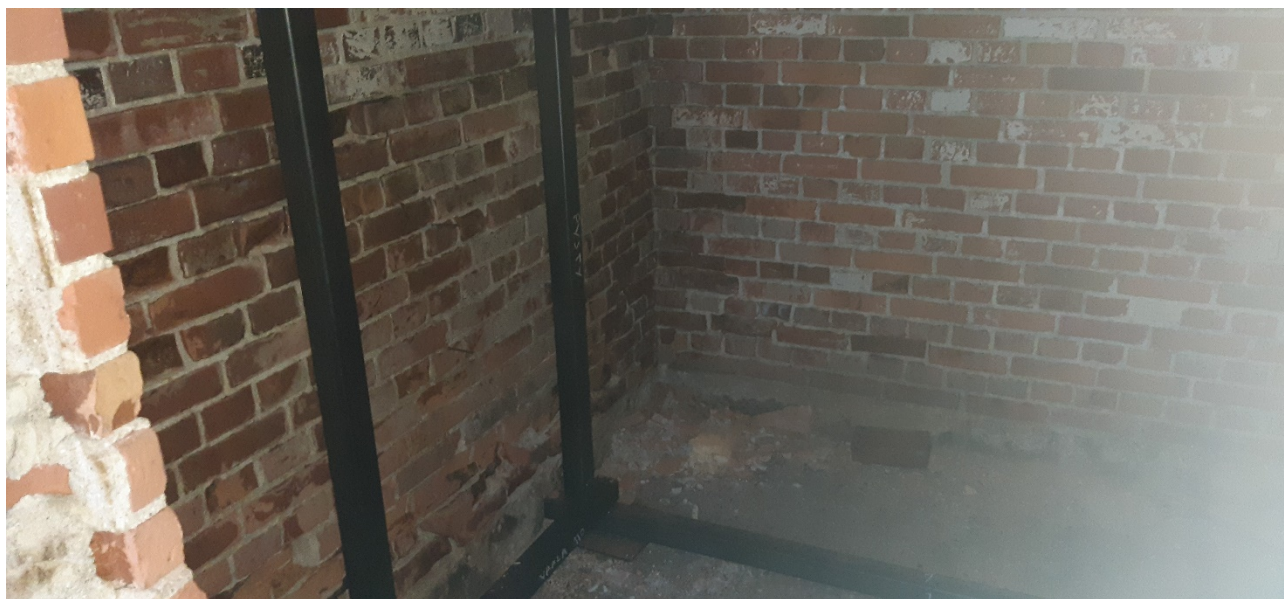
Teräspilareilla tuettu kellari sisältä.
