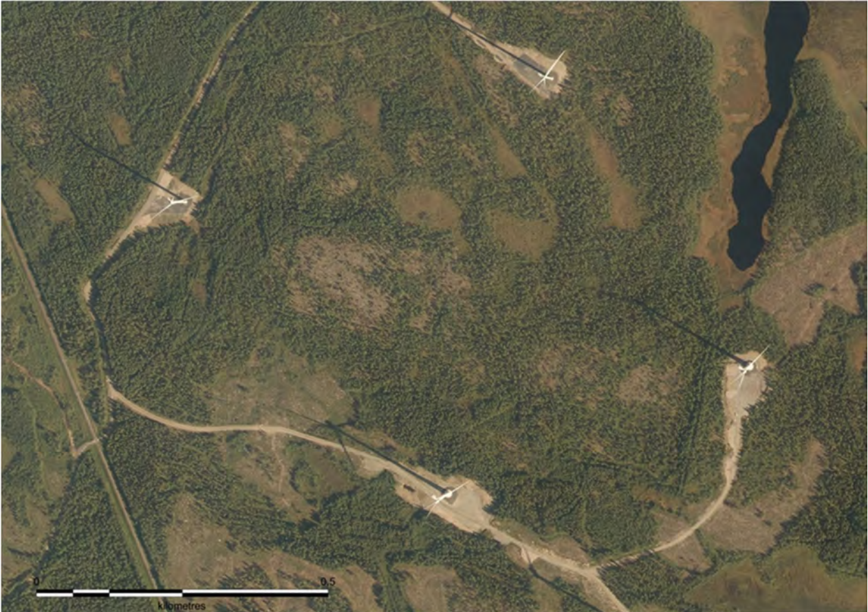
Kuva 62. Ilmakuvassa näkyy toiminnassa olevia tuulivoimaloita. Tuulivoimaloita varten on rakennettu huoltotiet ja nostokentät. Tuulivoimaloiden ympäristössä ja välialueilla aikaisempi maankäyttö on säilynyt ennallaan.
