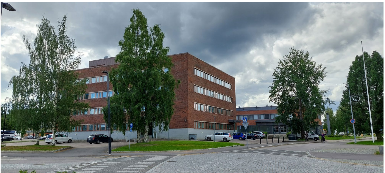
Kuva 7. Virastorakennukset Vieskankadun ja Virastokadun risteyksestä nähtynä.
