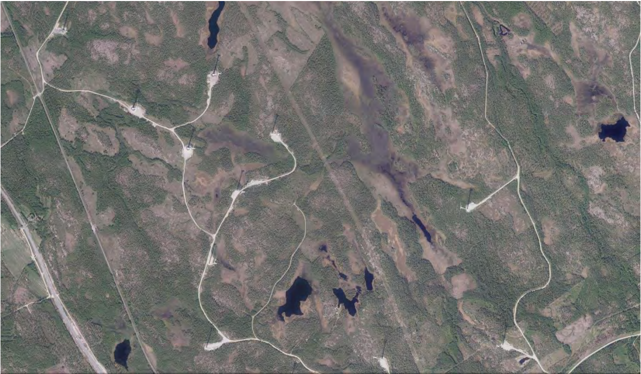
Kuva 18. Ilmakuvasa näkyvä tuulivoimapuisto huoltoteineen ja voimala-alueineen (lähde: Maanmittauslaitos, ilmakuva)
