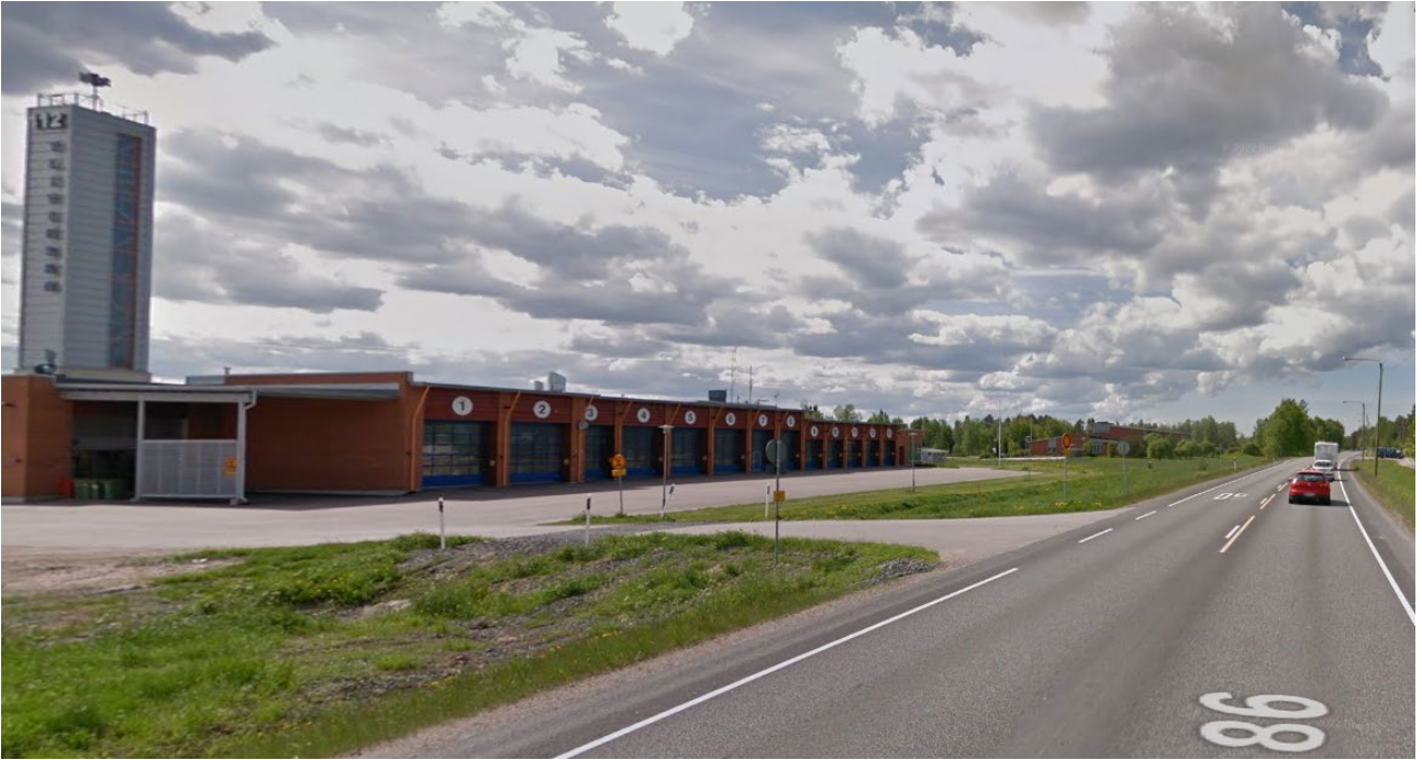
Kuva 5. Paloasema ja Rauhanyhdistyksen talo (takana) kantatien eteläpuolella. © Google 2017
